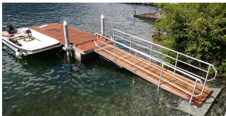
Figura 22: Altro esempio di molo galleggiante con colonne per l'ormeggio presenti sul lago di Como
