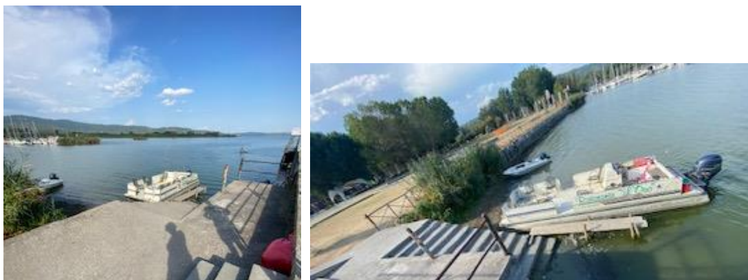
Figura 28: molo Busitalia di Tuoro con "adeguamenti provvisori" per imbarco su mezzi nautici ad uso privato
